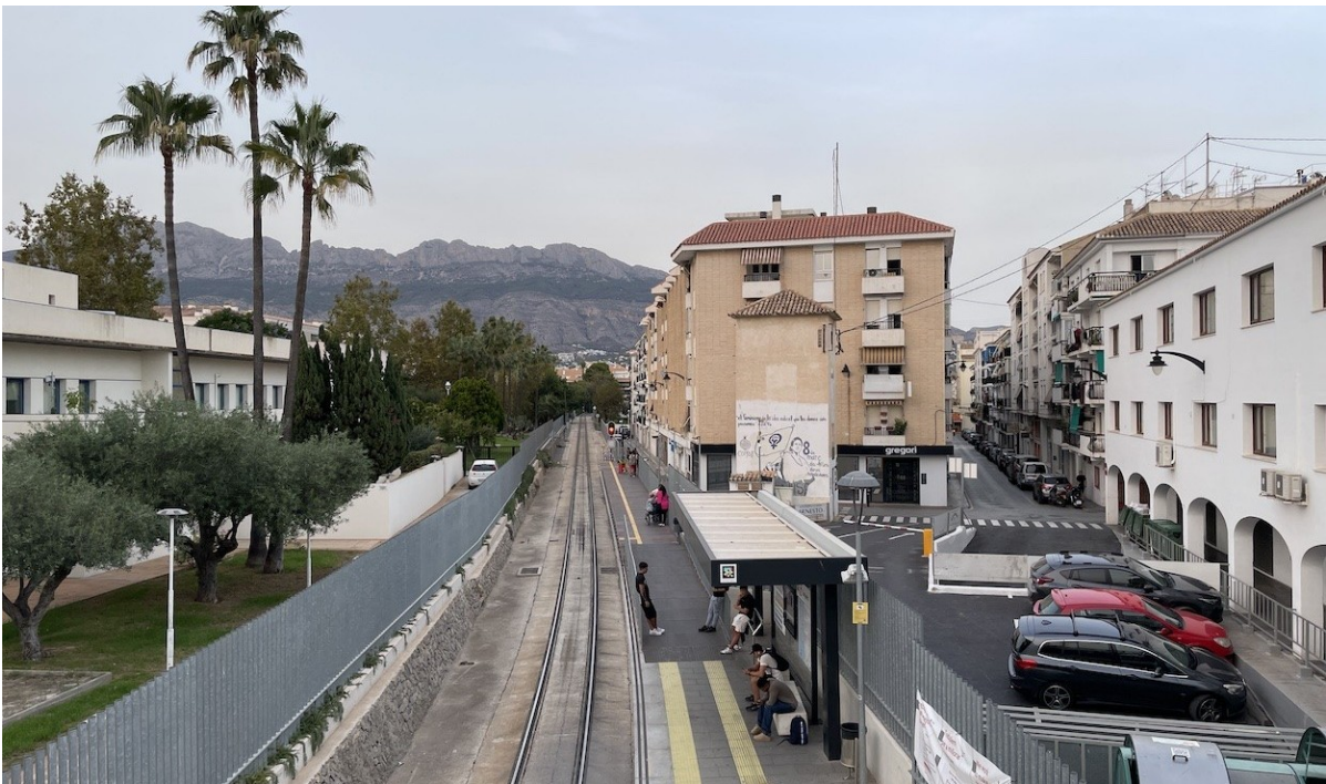
EL CORREDOR DEL TRAM EN ALTEA
